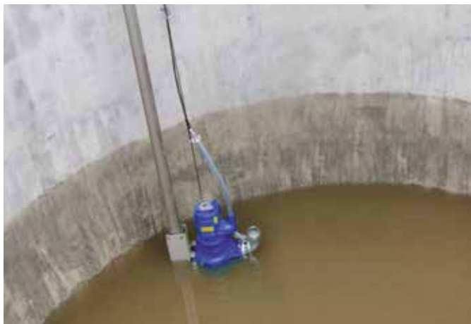
Подача подготовленного навоза к специальному прессовому шнековому сепаратору
