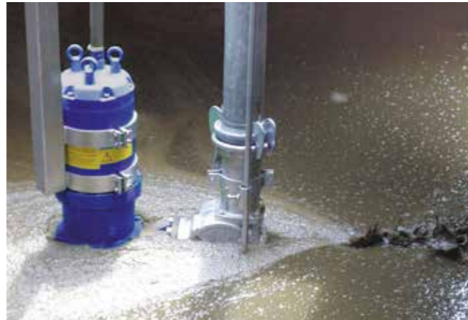
Загрузка установки специальным погружным насосом с измельчителем
